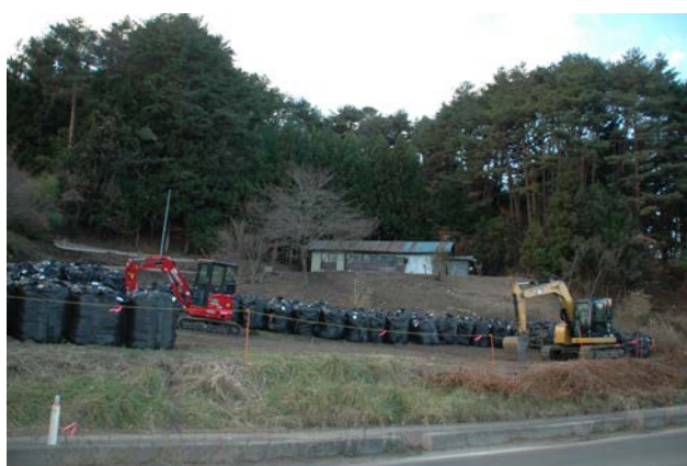
除染作業の様子 (飯舘村、2014年11月)
