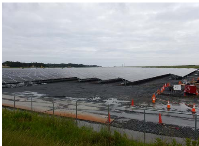
水田跡地に建設された大規模太陽光発電施設 (南相馬市、2019年6月)
