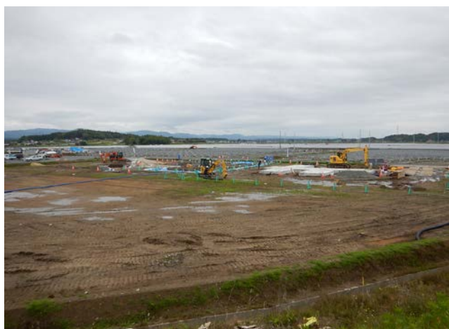
大規模太陽光発電施設の建設が進行 (南相馬市、2019年6月)
