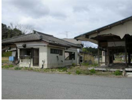
津波によって被害を受けた南相馬市の住宅 (2012年5月)
