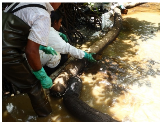
再浮上した油の回収作業
