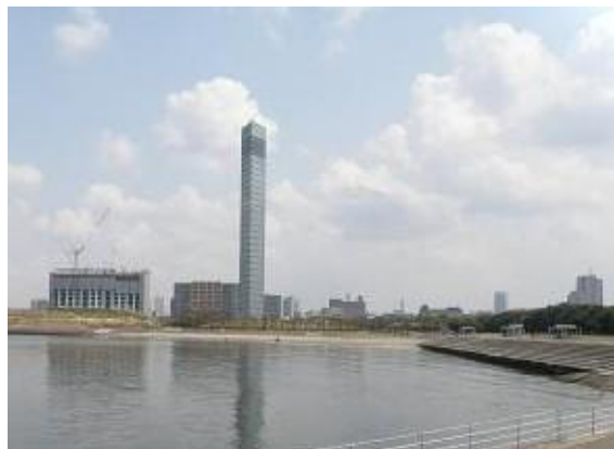
写真 1. 保護現場全景（3 月 30 日撮影）
